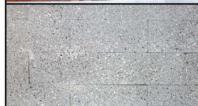
Ściana od wewnątrz po pracach malarskich
