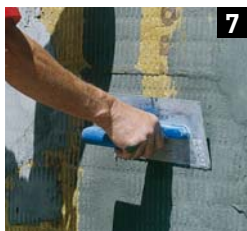
FASROCK LL – mocowanie płyt
